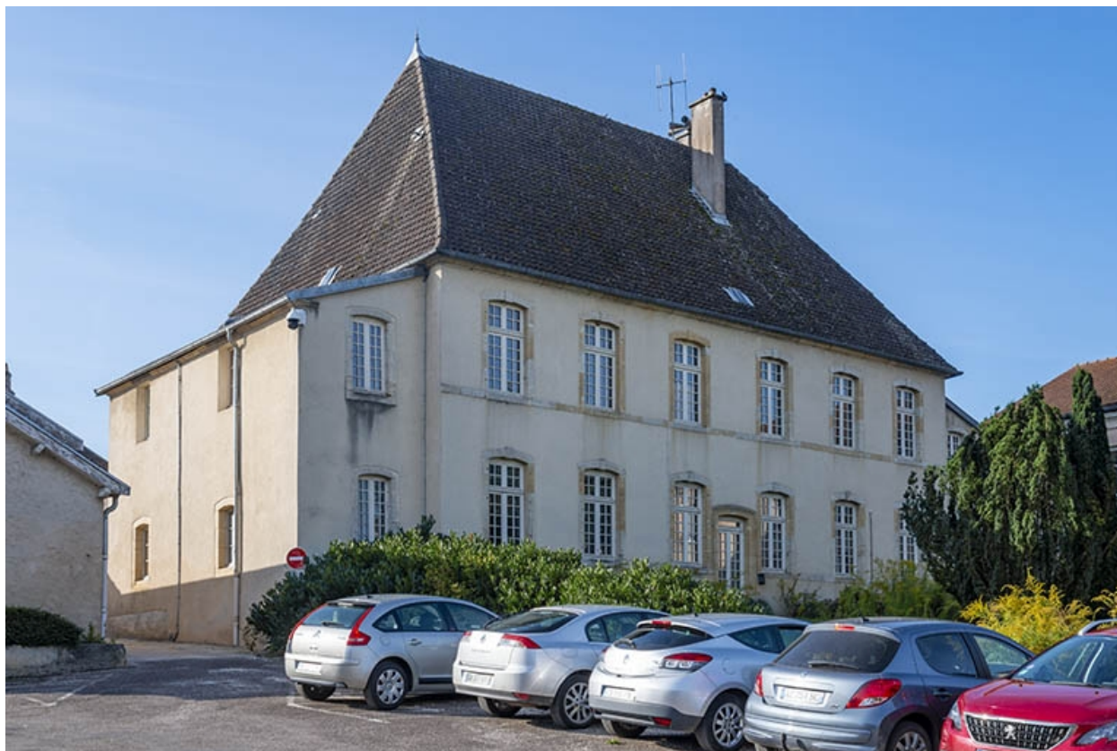
L'arrière, façade nord.
