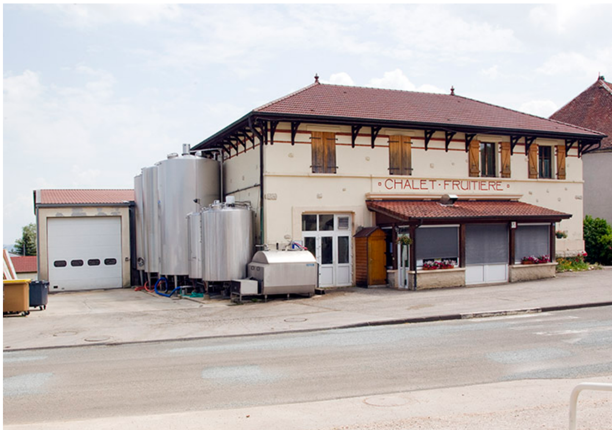
Façades antérieure et latérale gauche.
