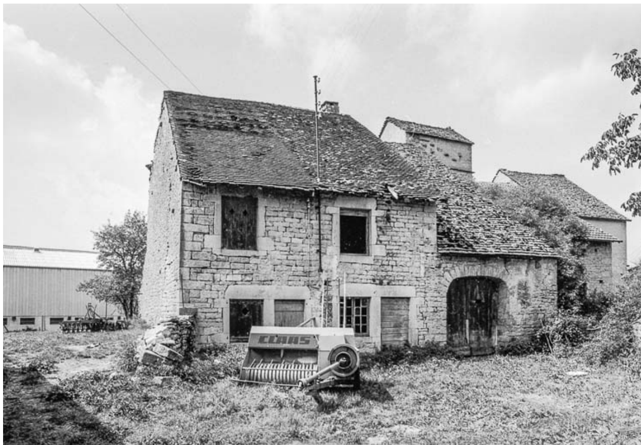
Ferme cadastrée 1951 E1 150 : vue d'ensemble.
