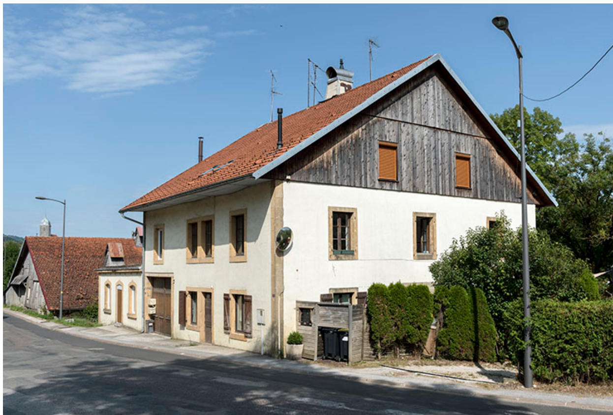
Façades antérieure et latérale droite.
