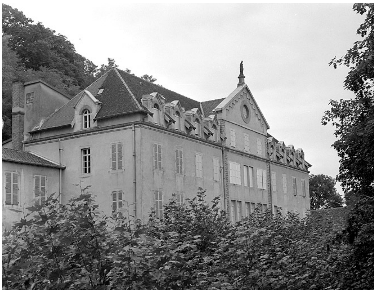
Façade antérieure du bâtiment D.
