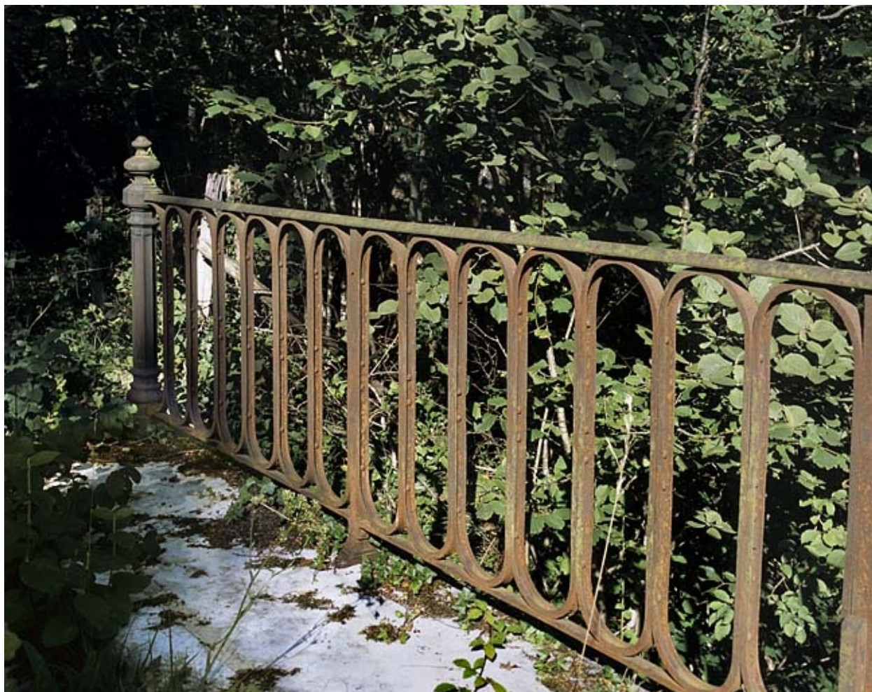
Détail d'un garde-corps.
