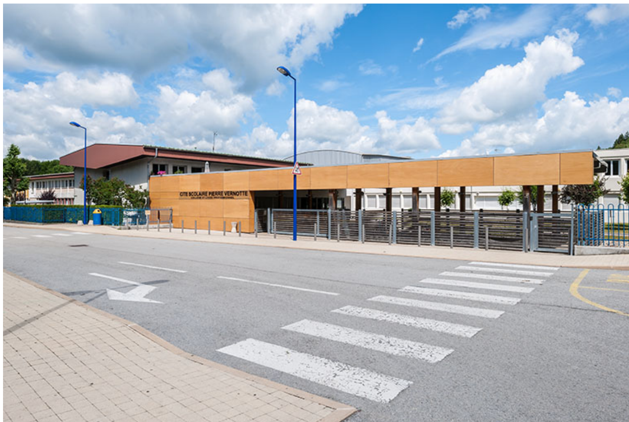
Entrée du lycée.
