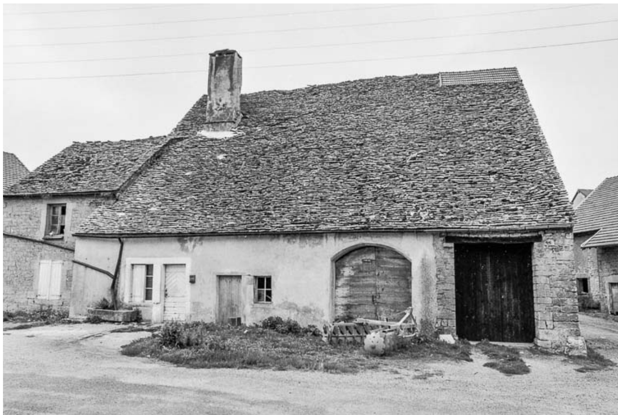
Ferme cadastrée 1951 E1 266 : façade antérieure.
