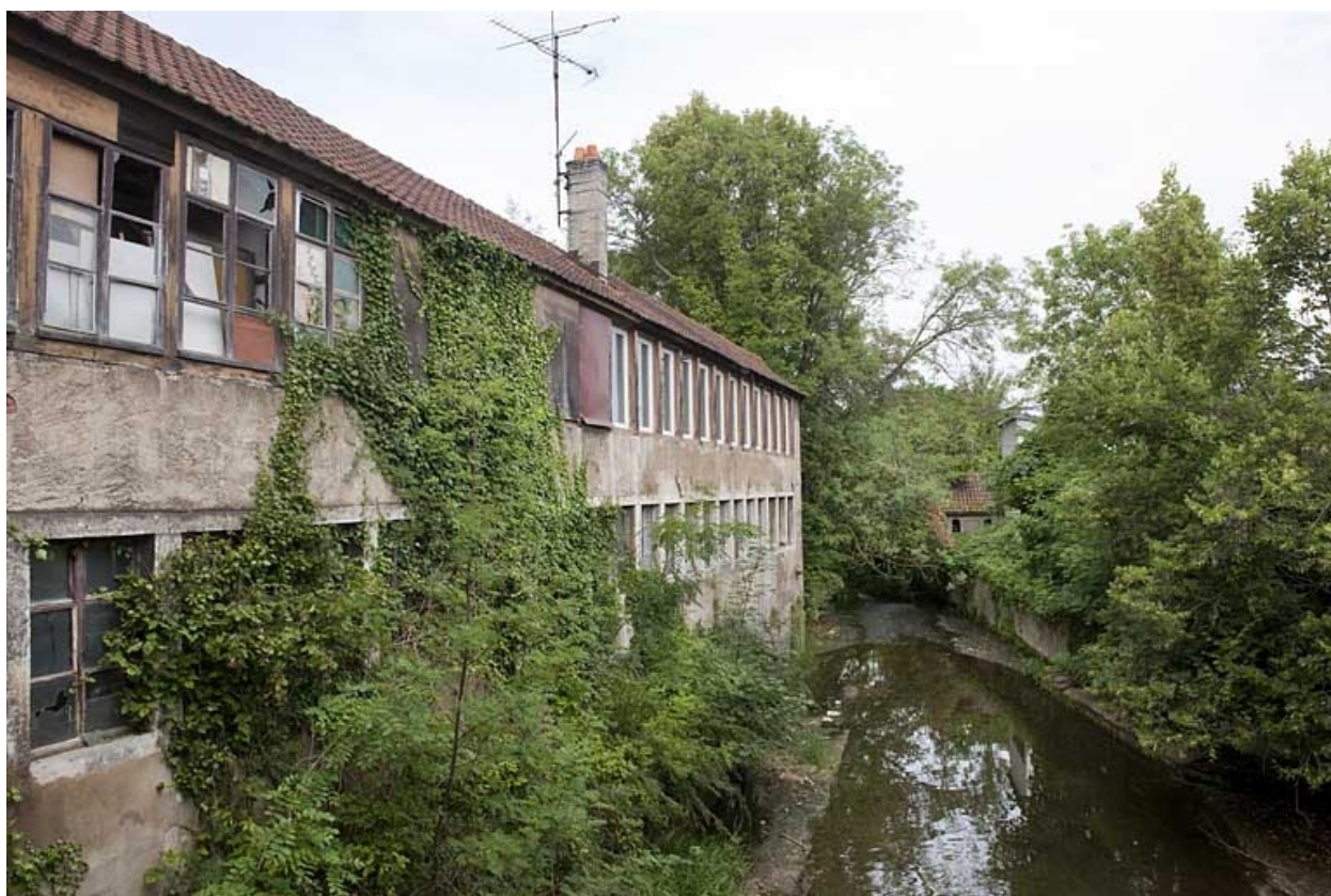
Usine Louis Boname, à Seloncourt (17 rue d'Audincourt).
