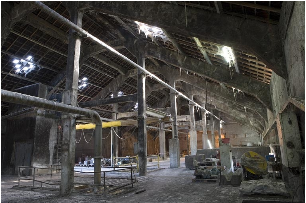
Atelier de trituration. Vue d'ensemble de la charpente en béton.
