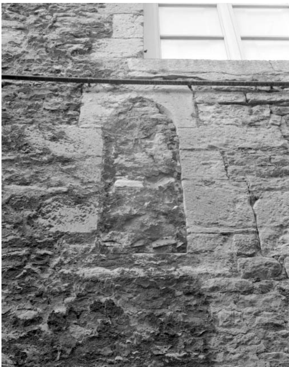
Façade latérale gauche : détail d'une baie murée.
