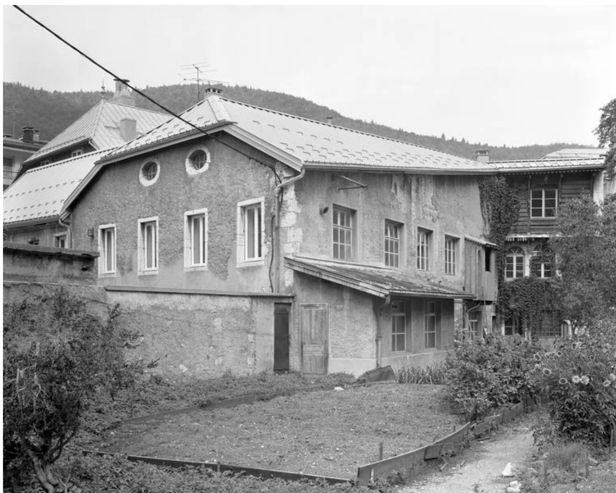
Façades latérale droite et postérieure de l'usine.
