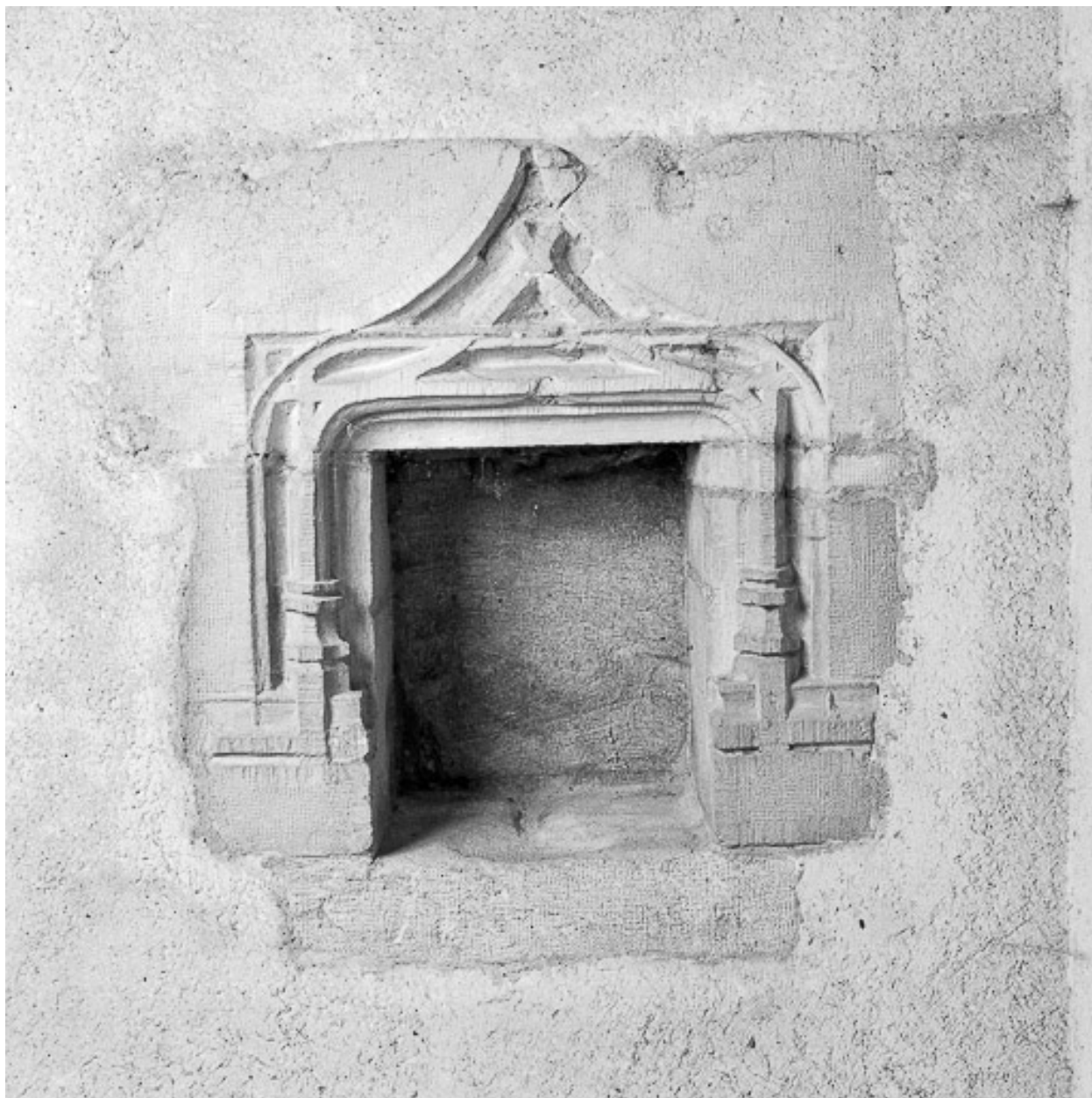
Niche dans un mur intérieur.
