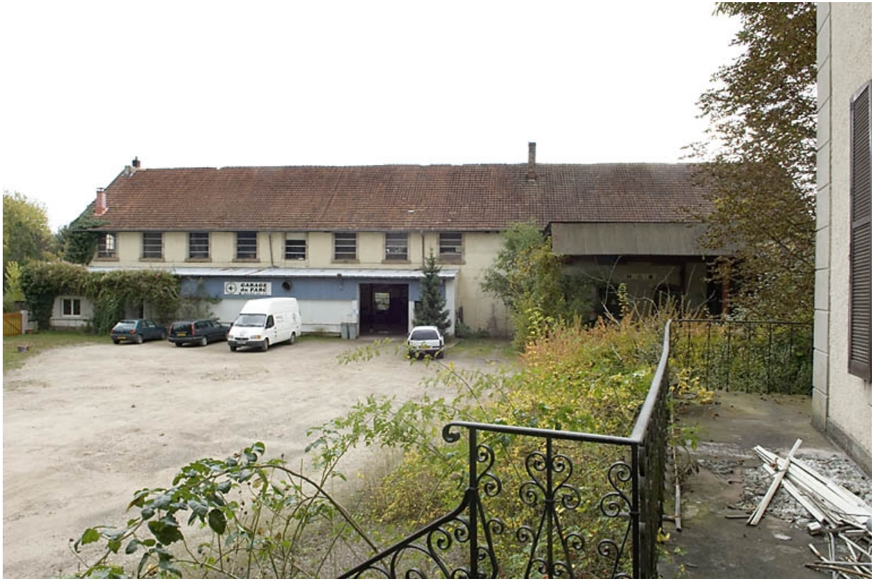
Atelier de fabrication. Vue depuis le nord-ouest.
