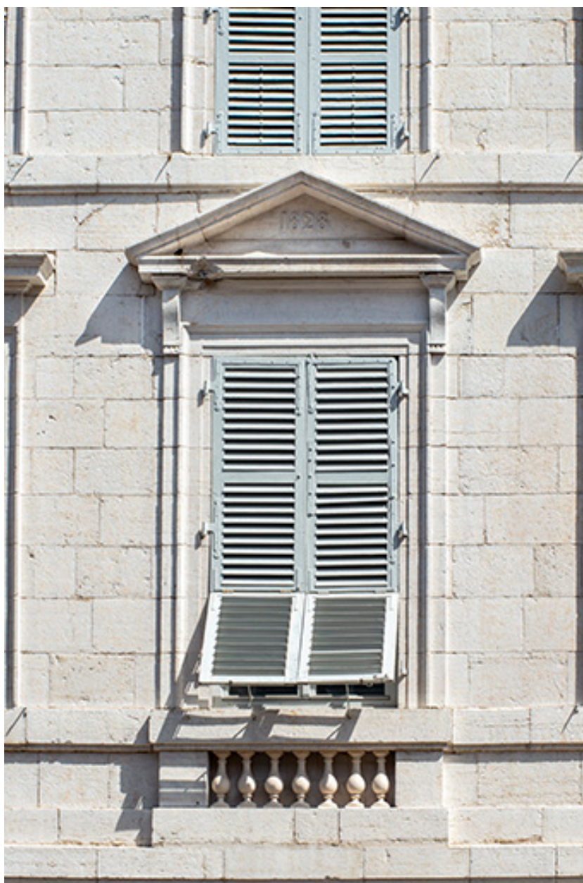
Fenêtre centrale du premier étage.
