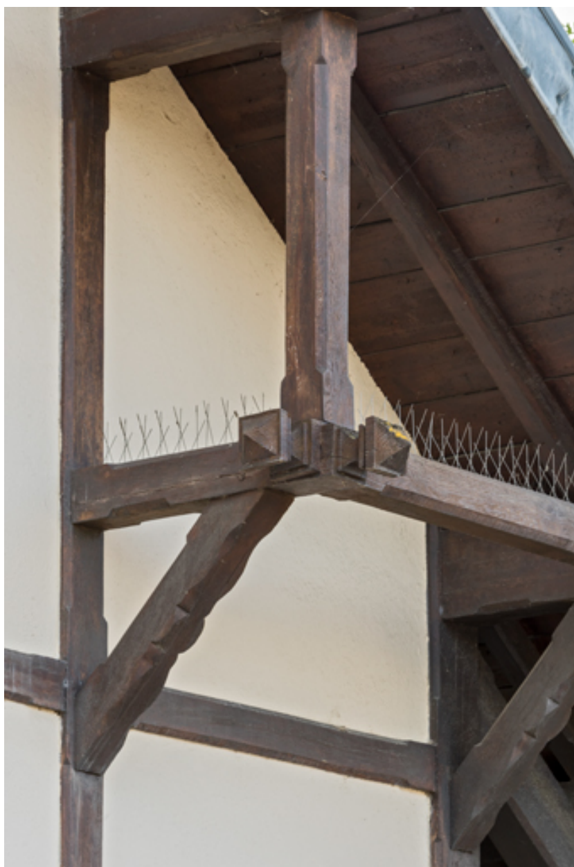
Détail de la charpente en bois.
