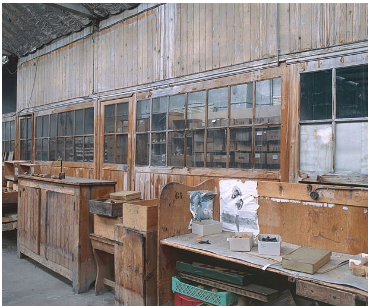
Cloison vitrée d'un atelier de vérification.
