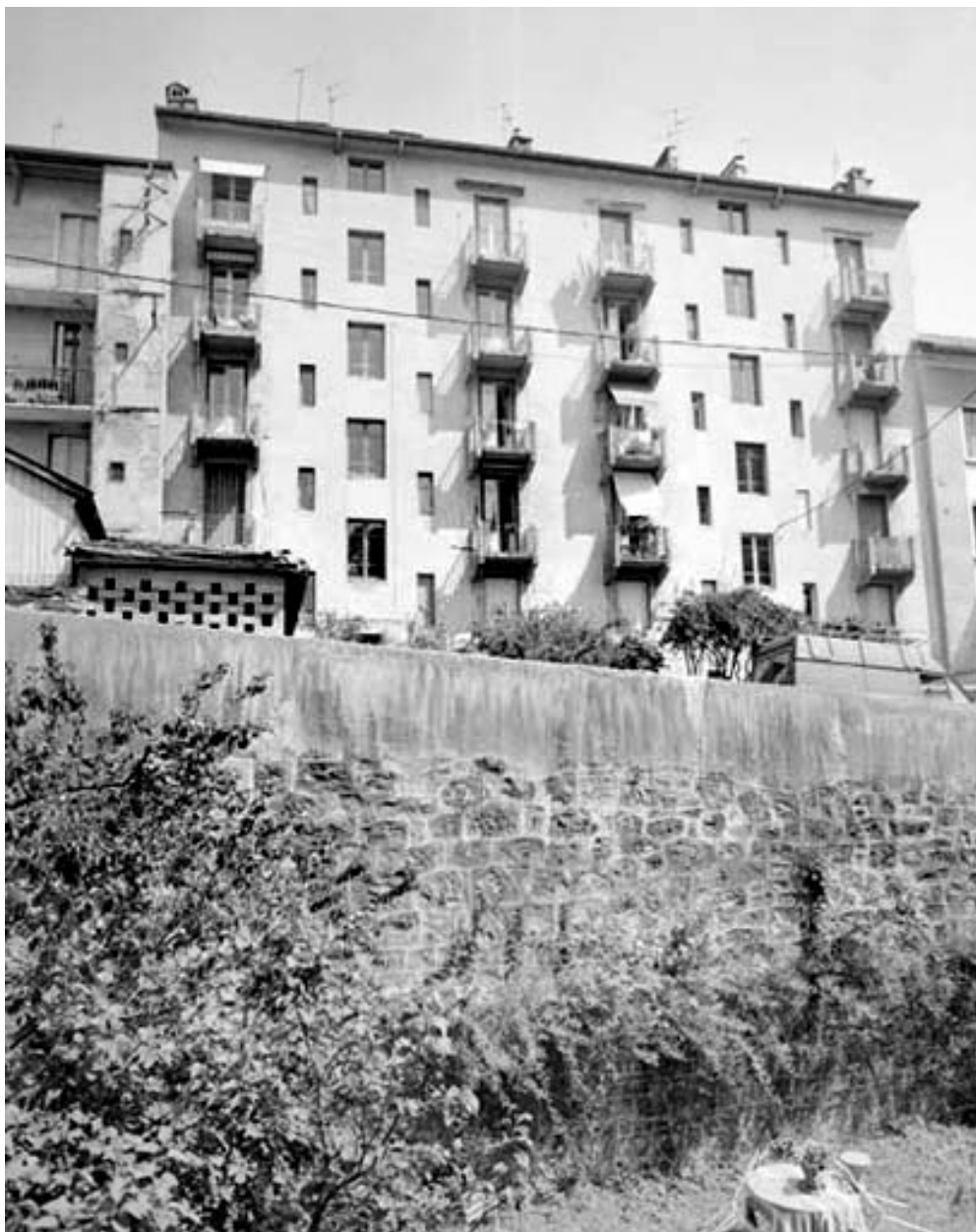
Façade postérieure de l'immeuble aux 15-17, rue Lançon.
