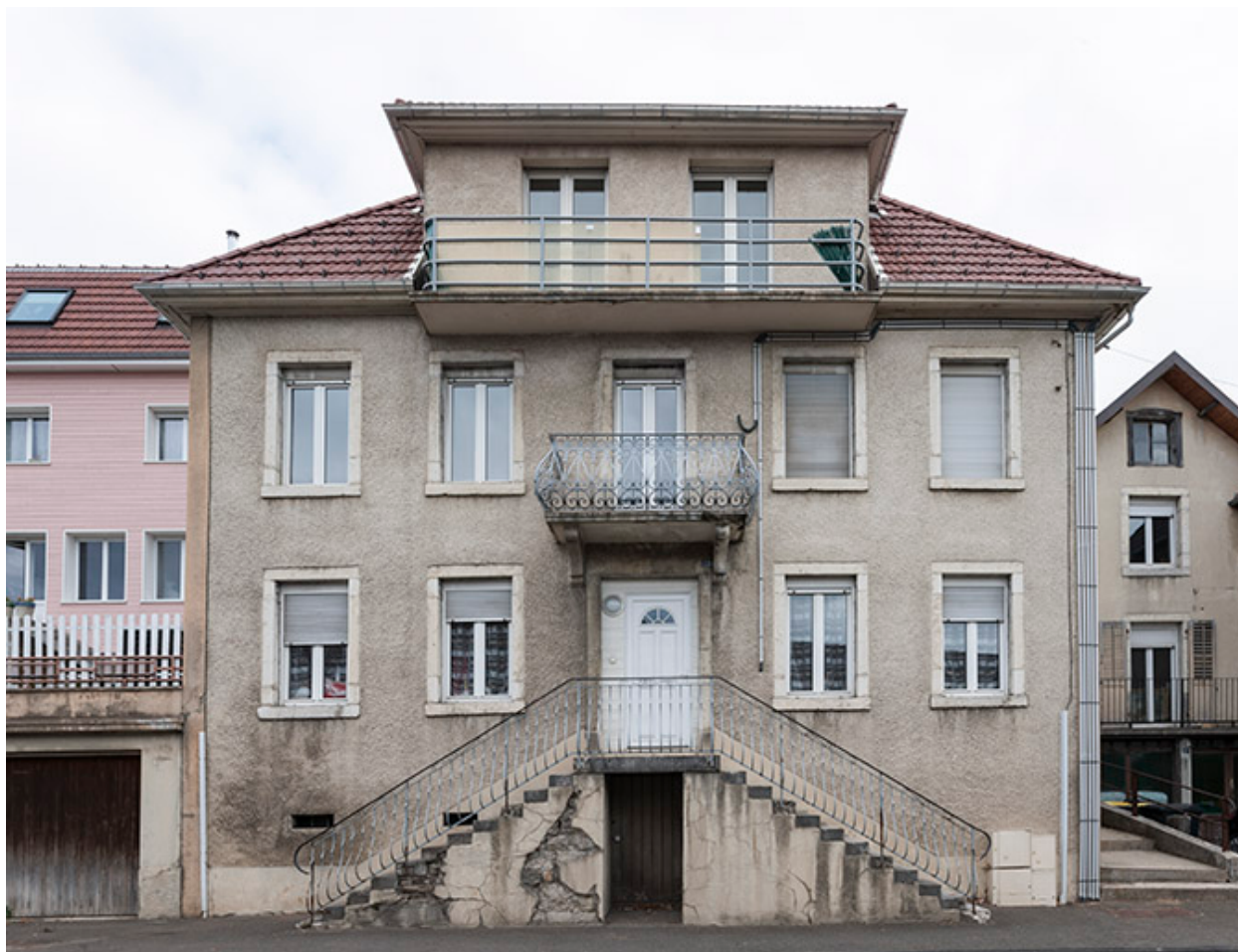
Maison : façade antérieure.
