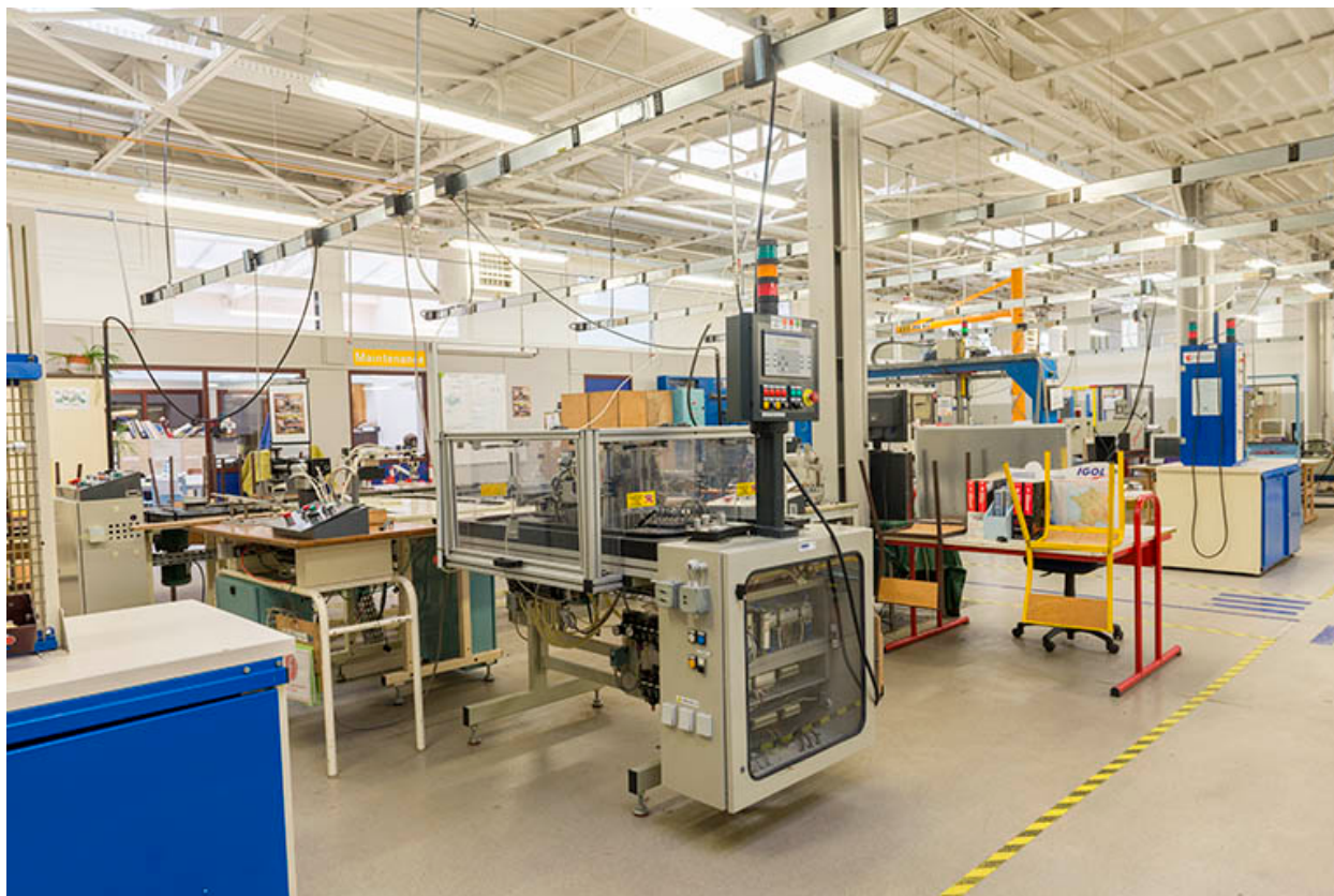
Vue intérieure d'un atelier.
