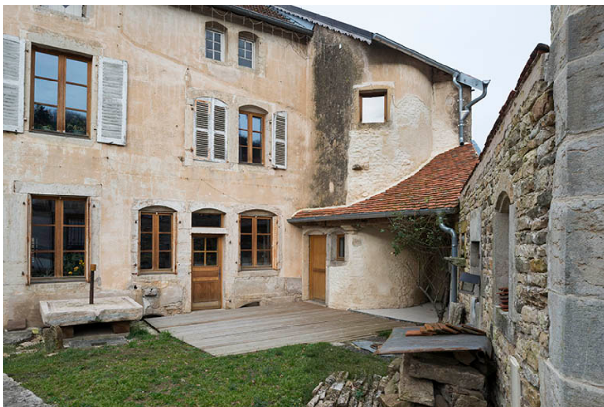
La tour d'escalier, vue extérieure.
