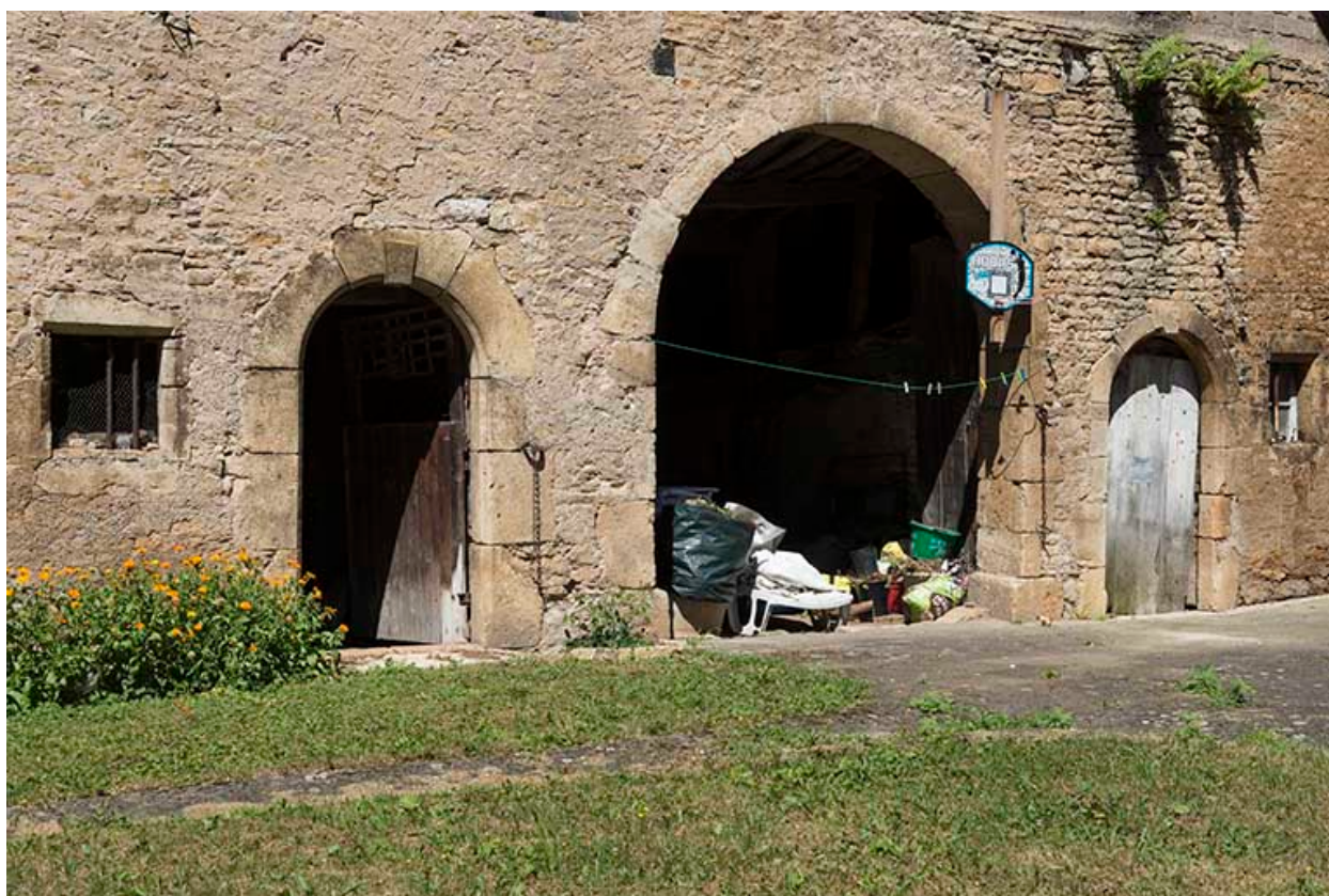
Portes de la remise.
