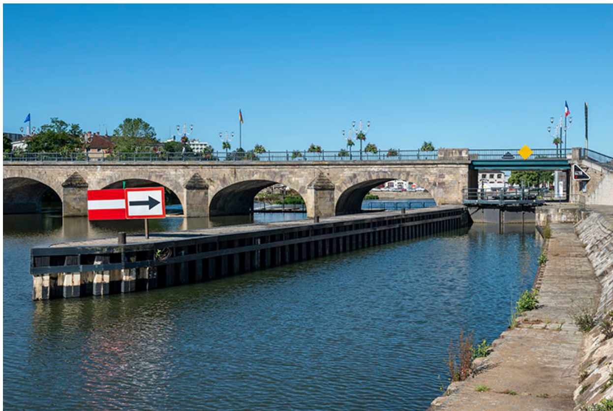
Vue amont de l'arche marinière à Gray.
