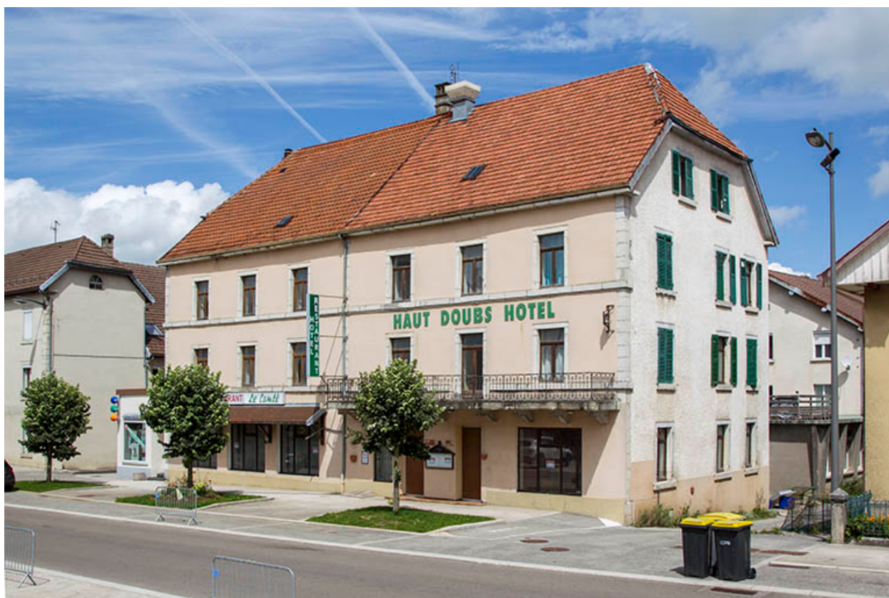
Façades antérieure et latérale droite.
