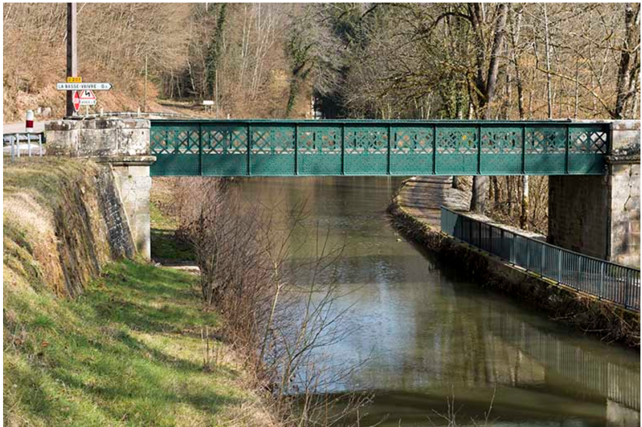
Vue sur la passerelle enjambant le canal.
