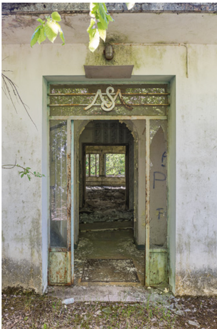
Bâtiment principal, façade postérieure, porte d'entrée.
