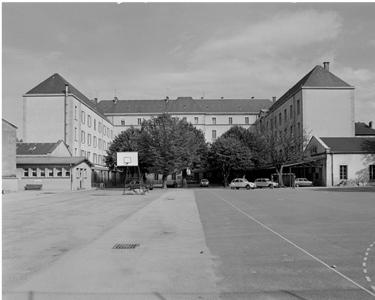
Façades des bâtiments sur la cour.
