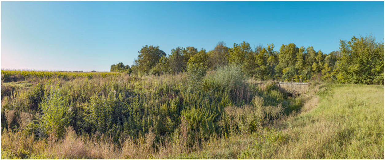
Le ponceau dans son environnement.
