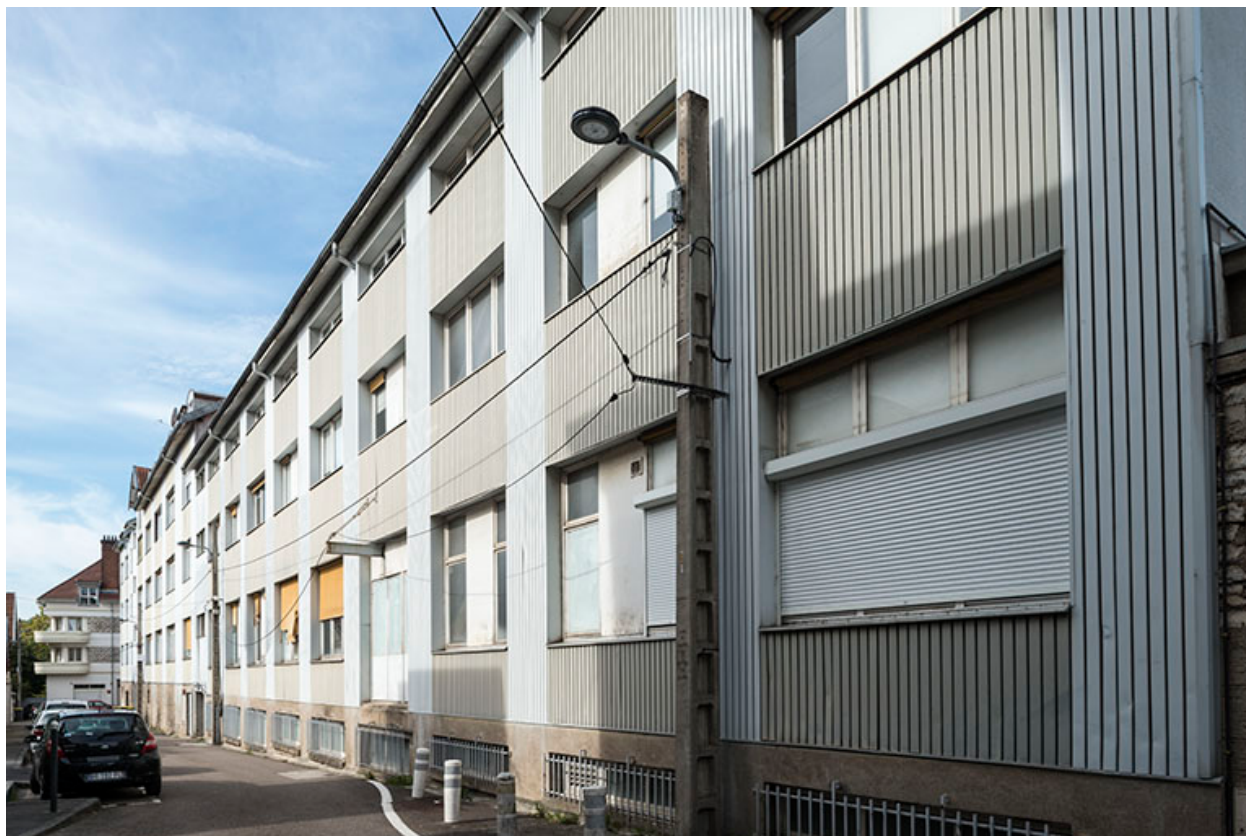
Façade du bâtiment sud.
