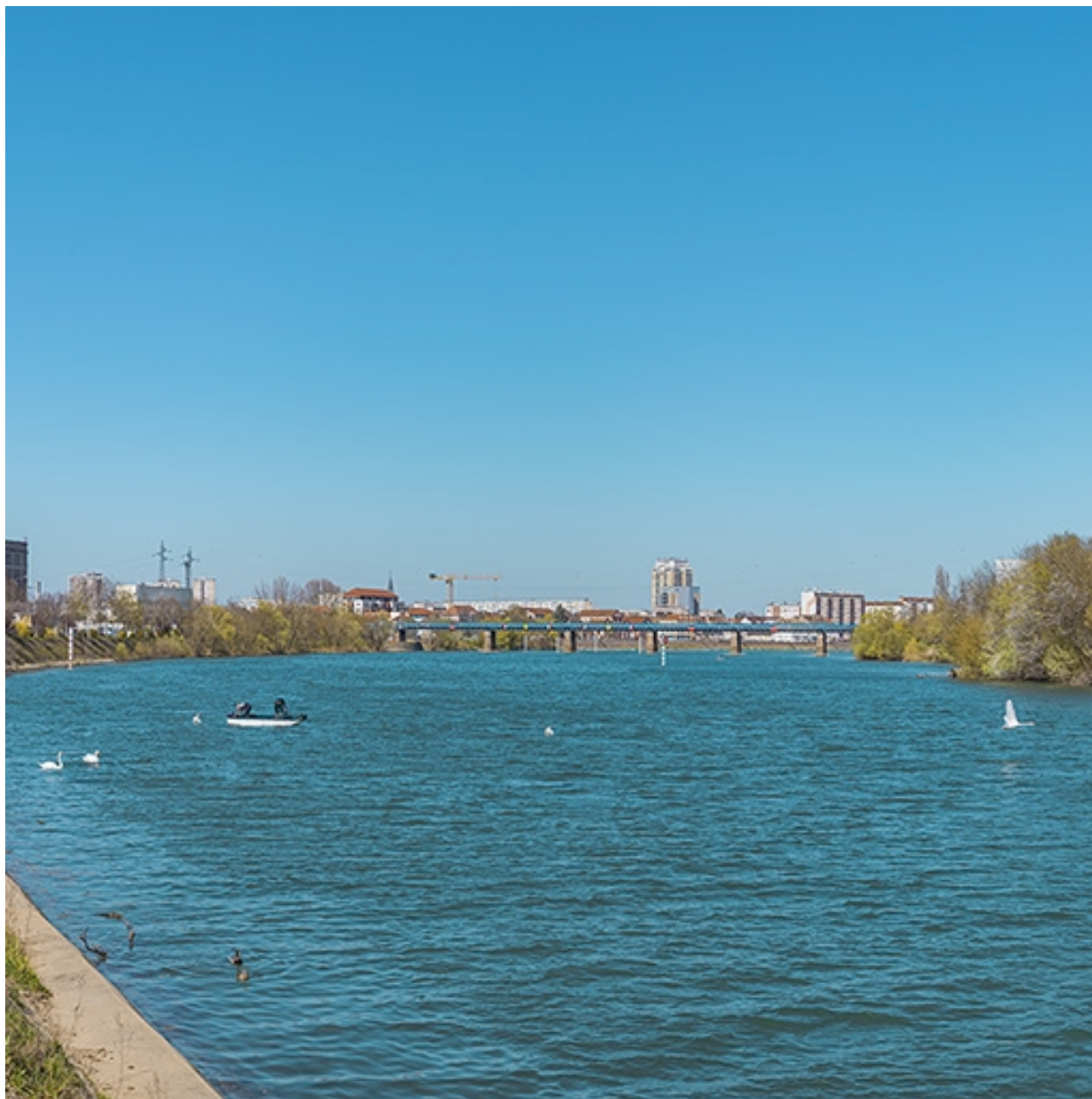
Vue d'ensemble du pont, depuis l'aval.
