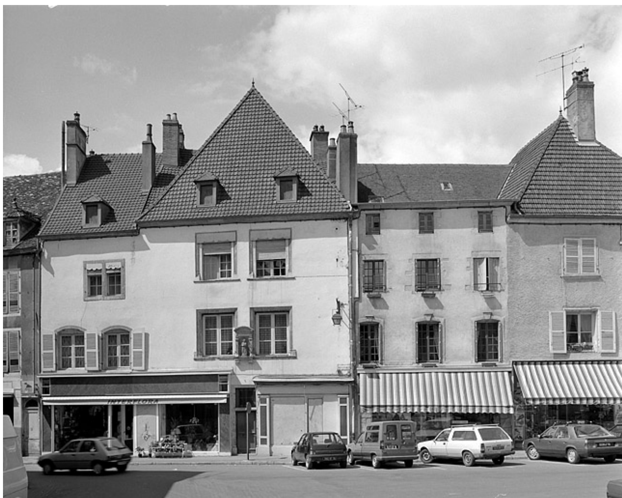
Vue d'ensemble façade antérieure, de face.
