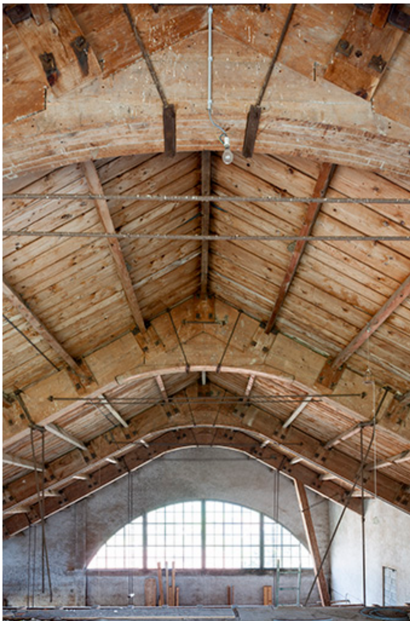
Vue axiale de la charpente, depuis l'ouest.
