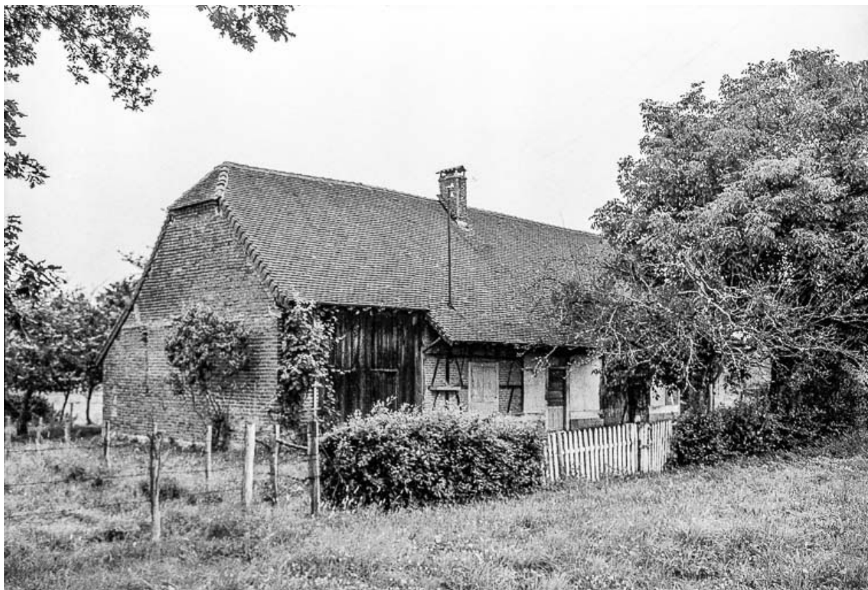
Ferme cadastrée 1969 AE 43 : façade antérieure.
