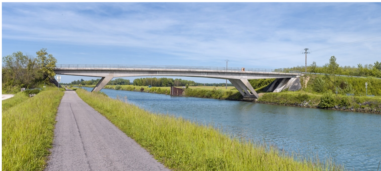
Vue d'ensemble d'amont, rive gauche.
