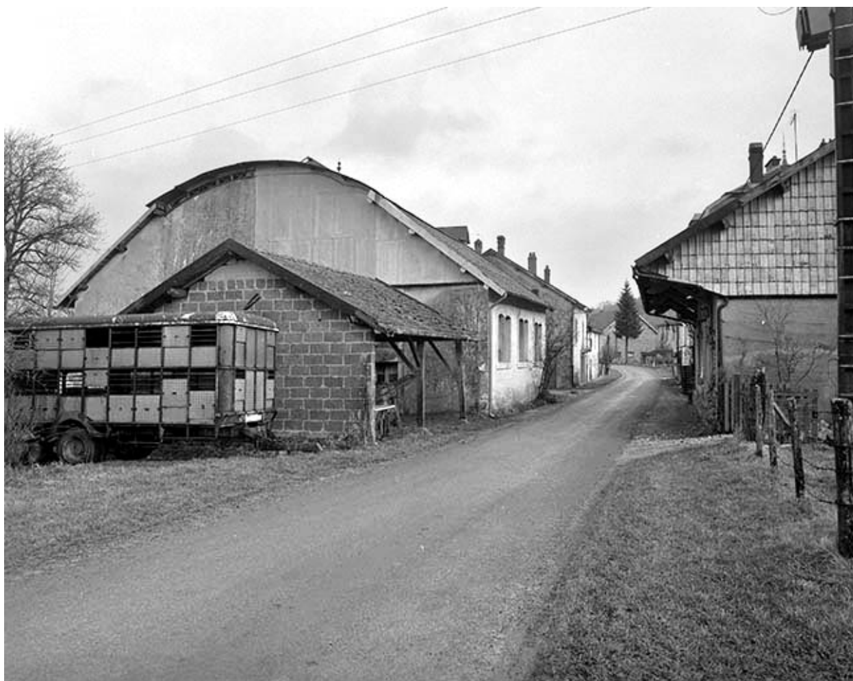
Ateliers de fabrication depuis le sud.
