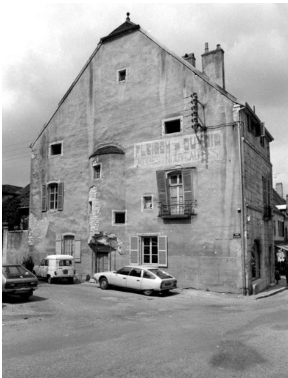
Façade donnant sur la place des Promenades.
