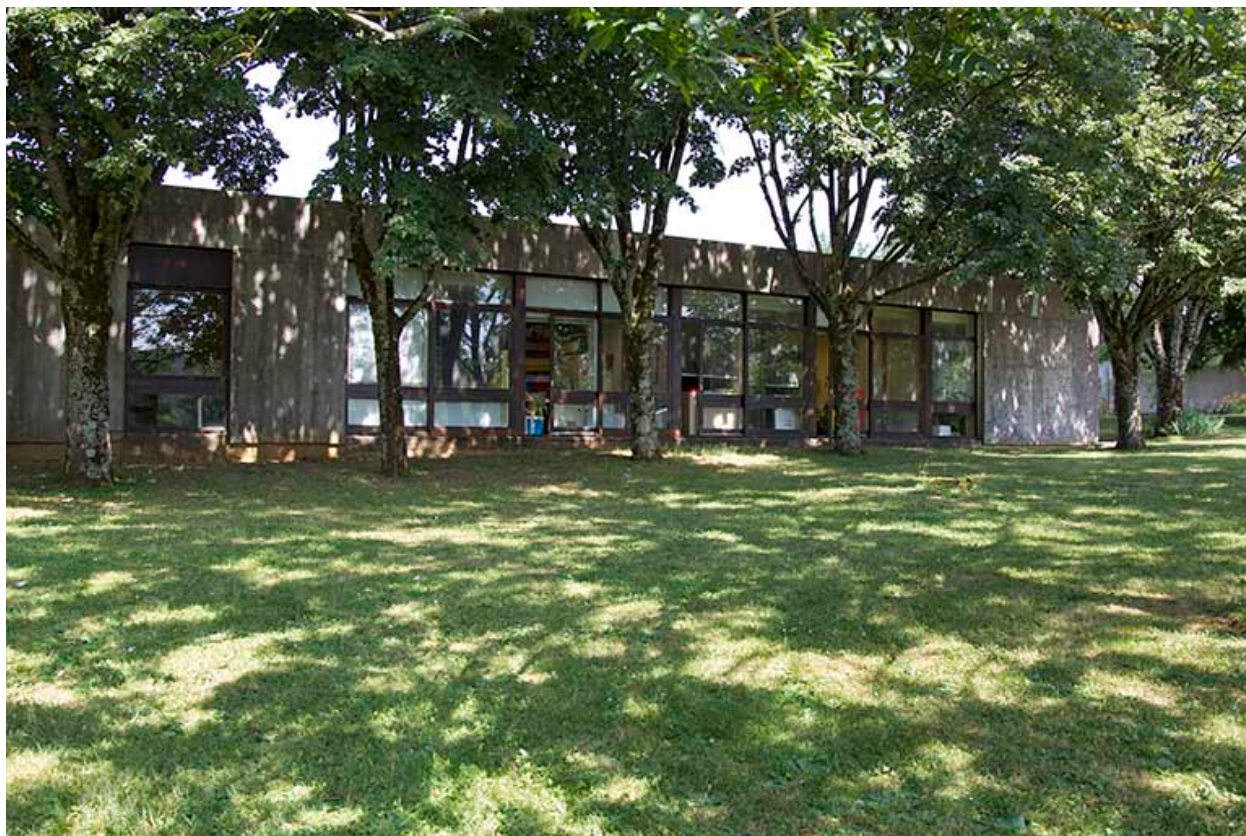
Façade postérieure - ouest - de l'administration.
