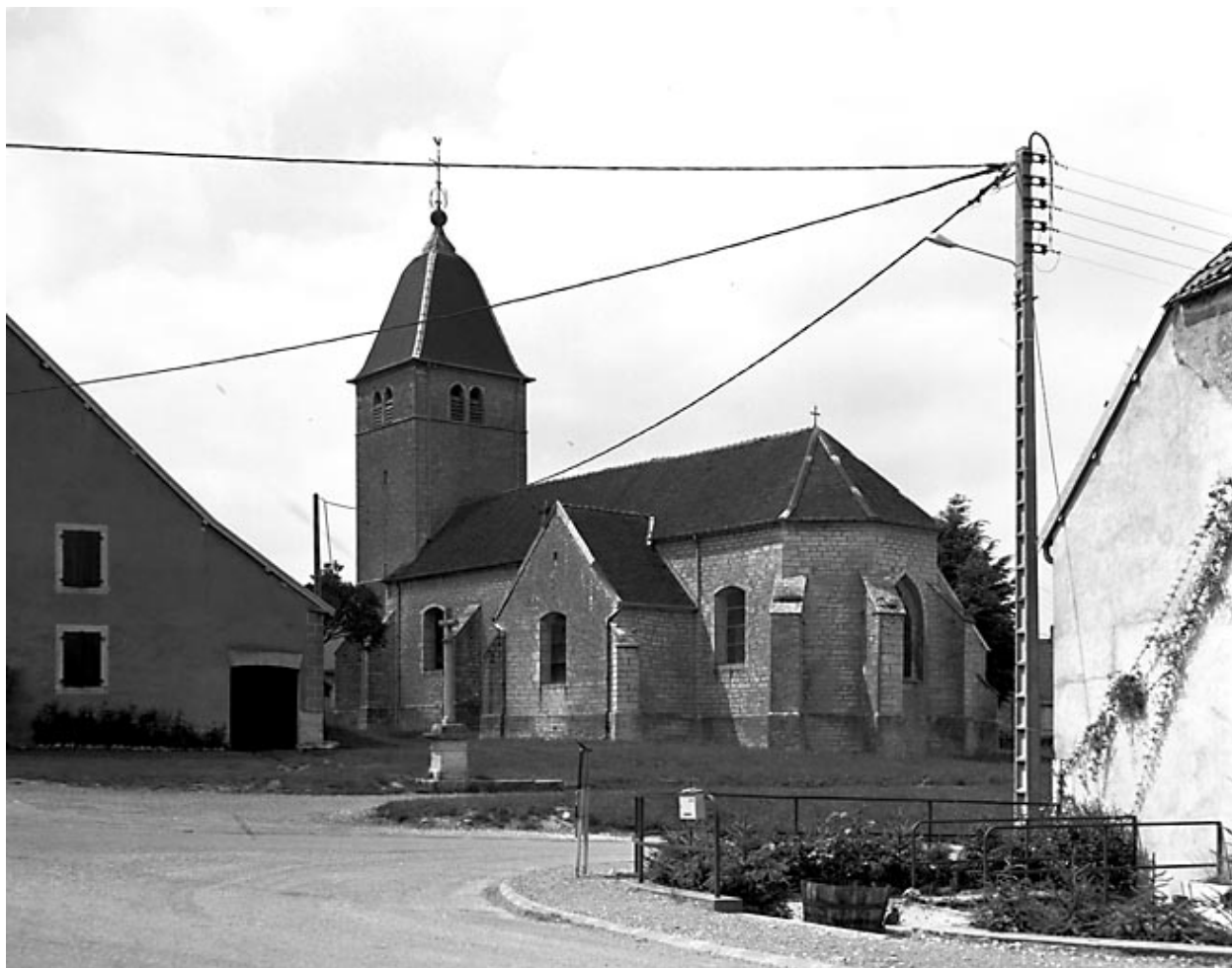
Chevet et façade latérale droite.
