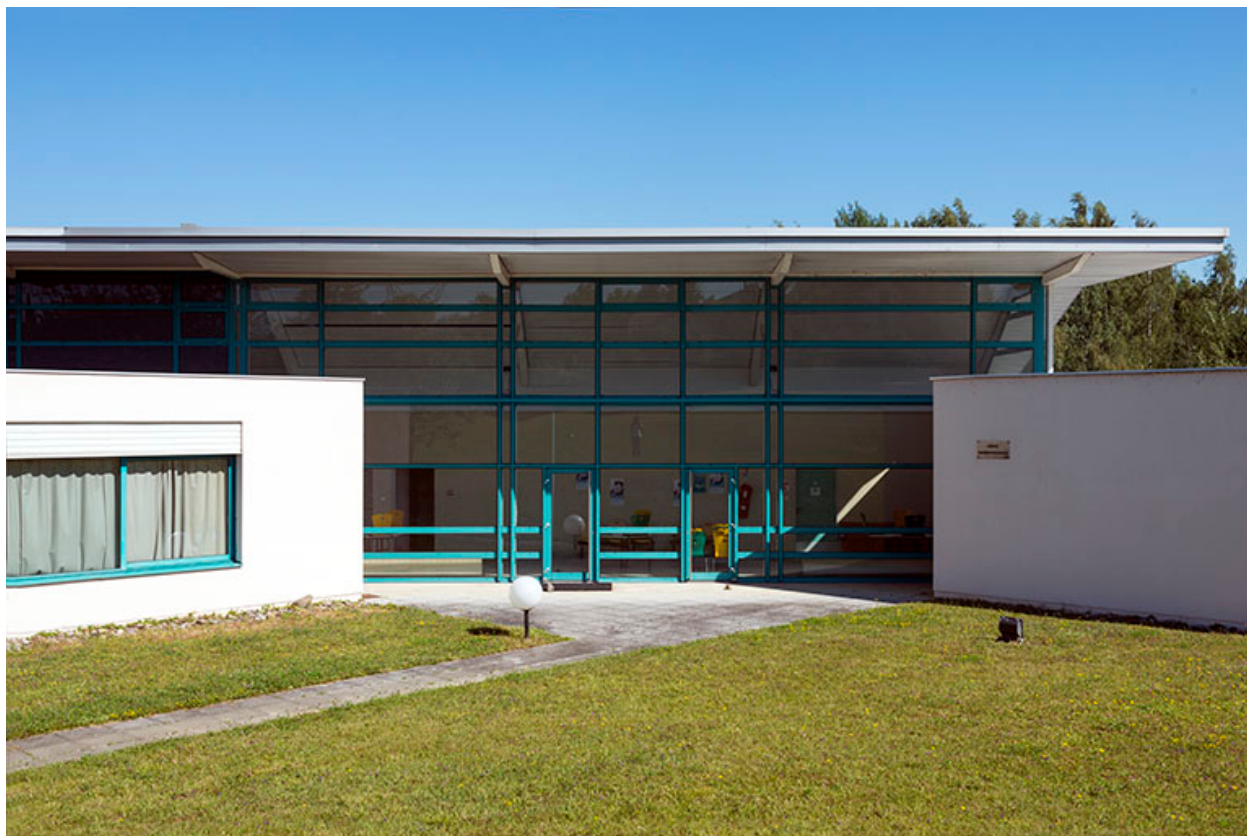
Détail façades sud des bâtiments de plasturgie.(ex-Léger)
