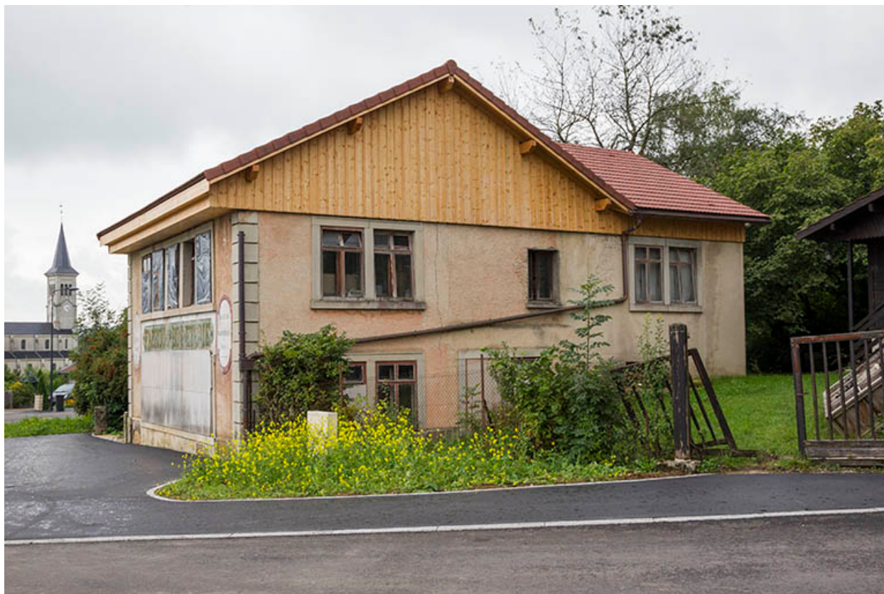
Usine : façade latérale droite (vue d'ensemble).
