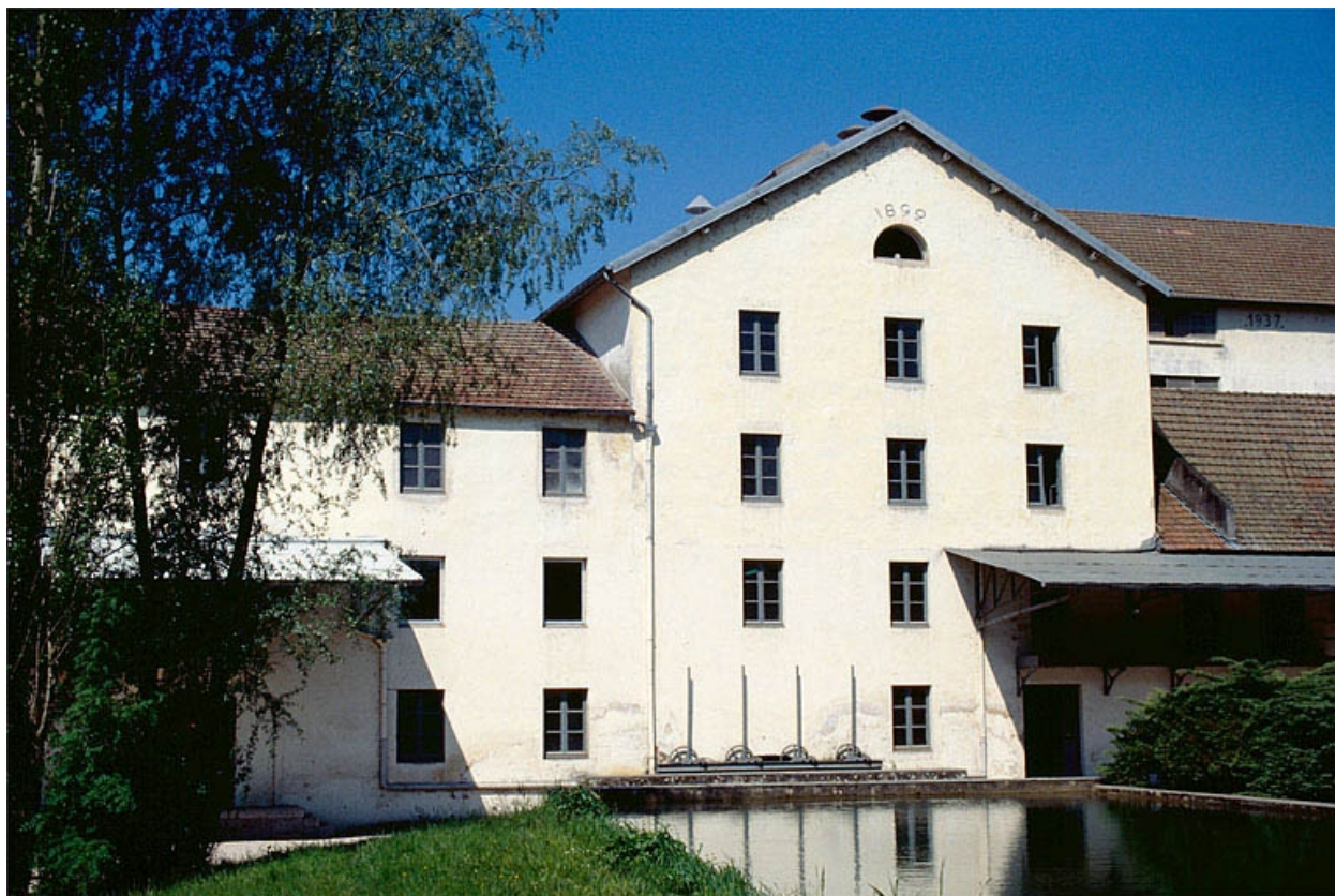
Façade antérieure de l'atelier de fabrication (L).
