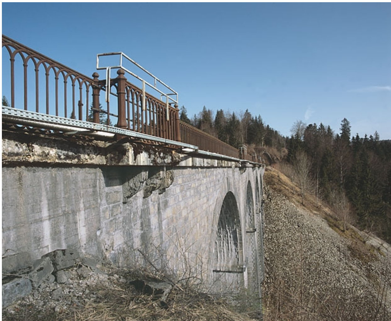
Garde-corps de l'élévation orientale.
