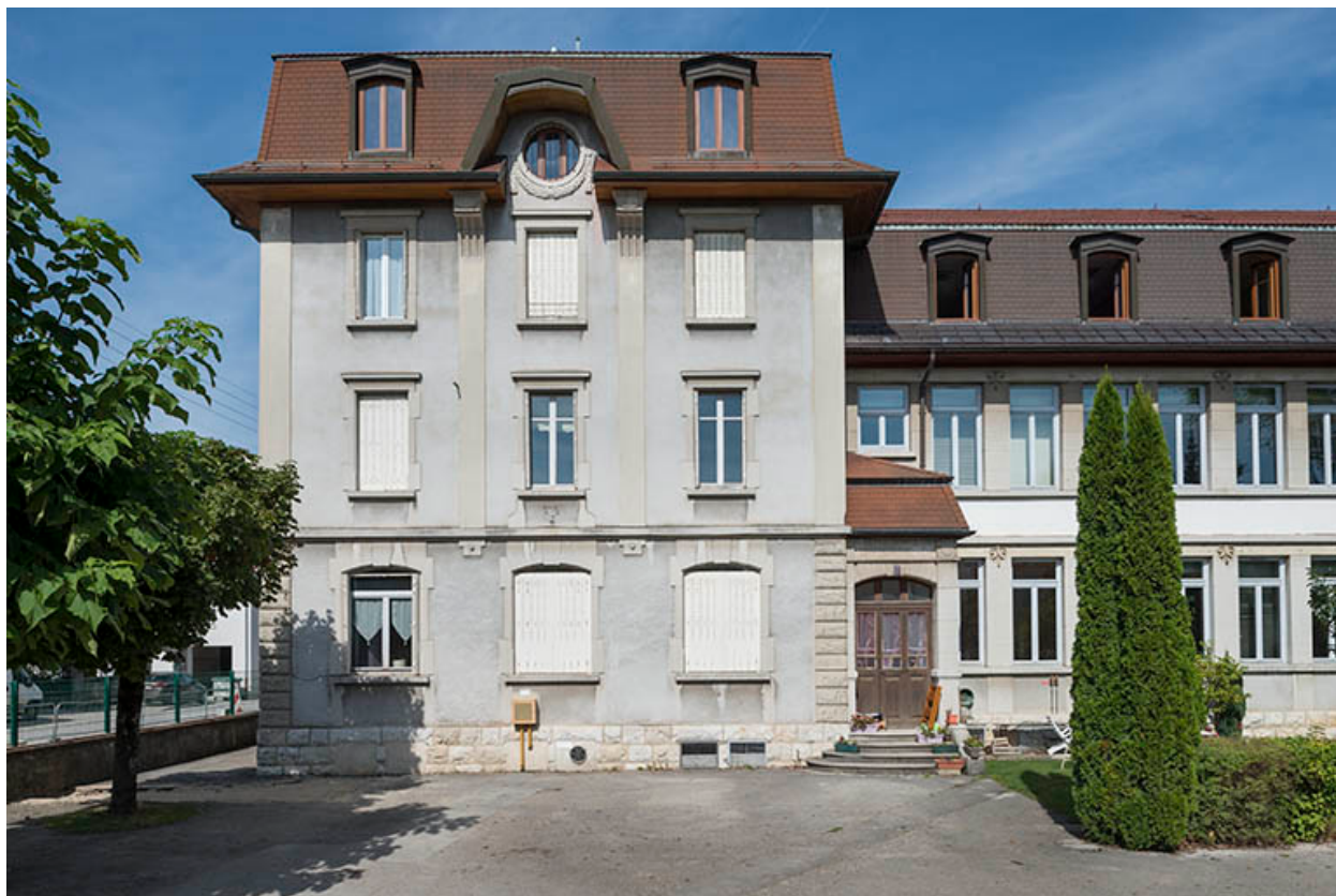
Pavillon ouest : bureau et logements.
