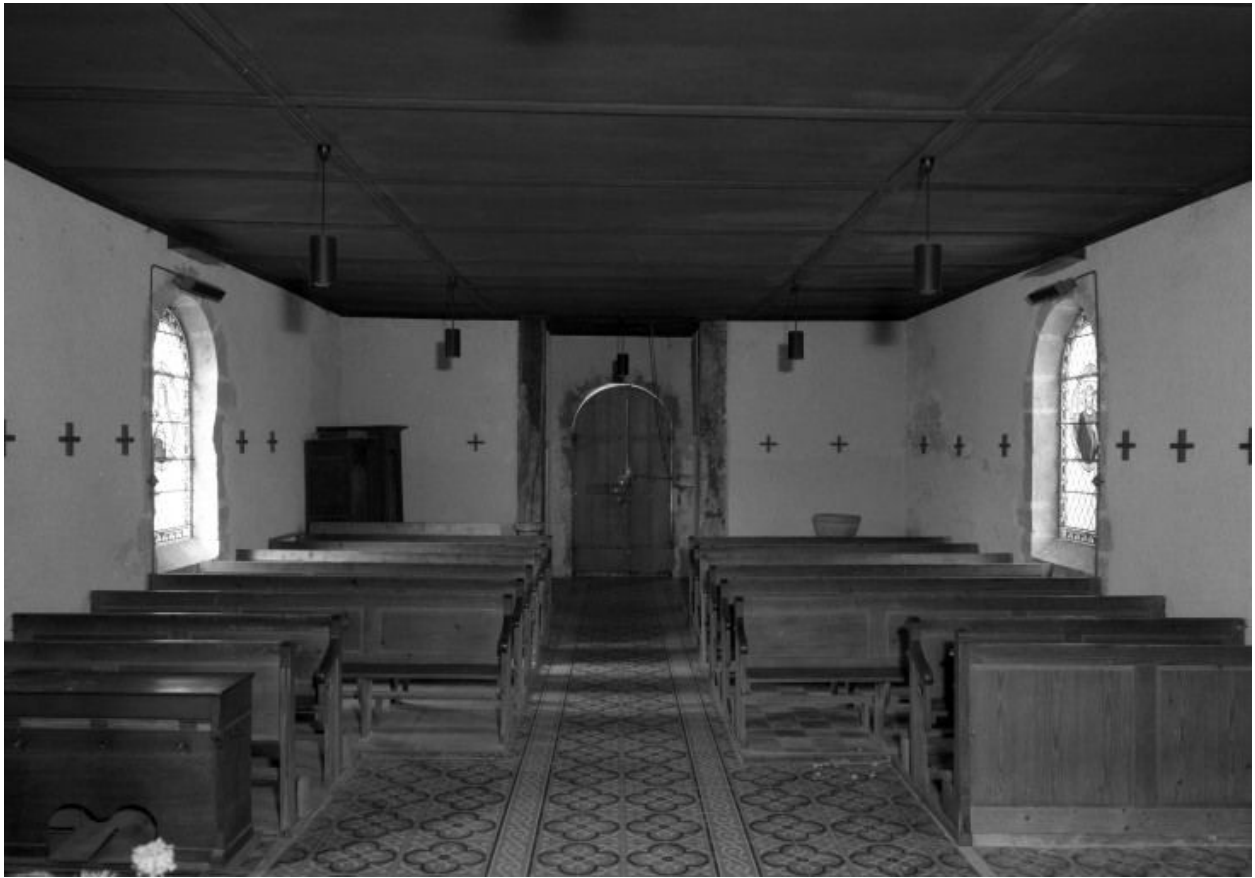
Vue intérieure prise du choeur
