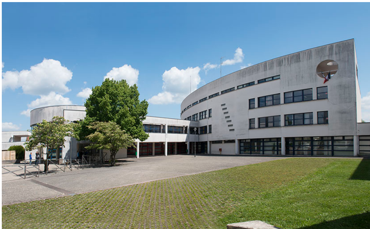
Cour et façade antérieure nord-ouest de l'externat.
