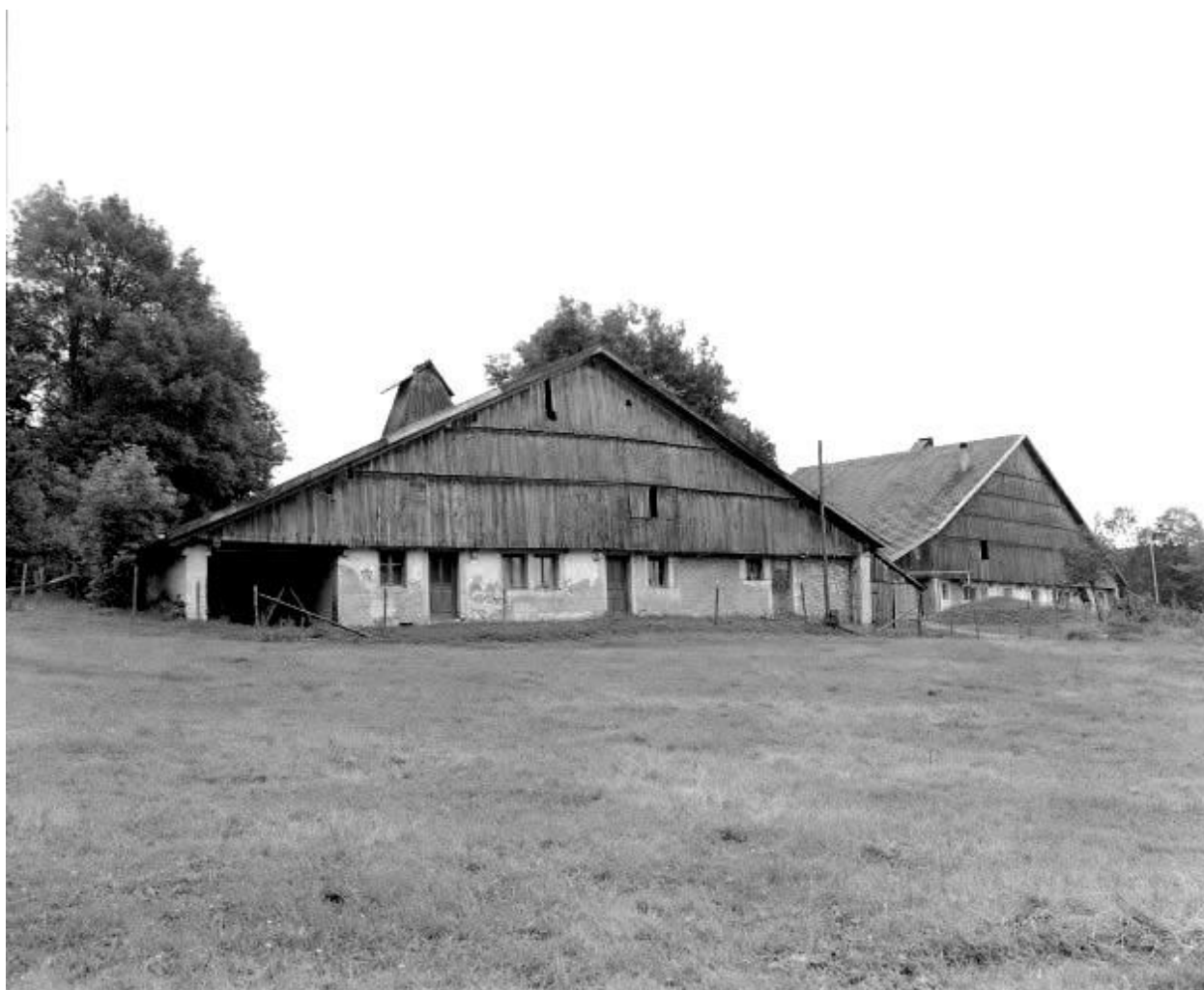
Fermes 1 et 2 : façades antérieures.
