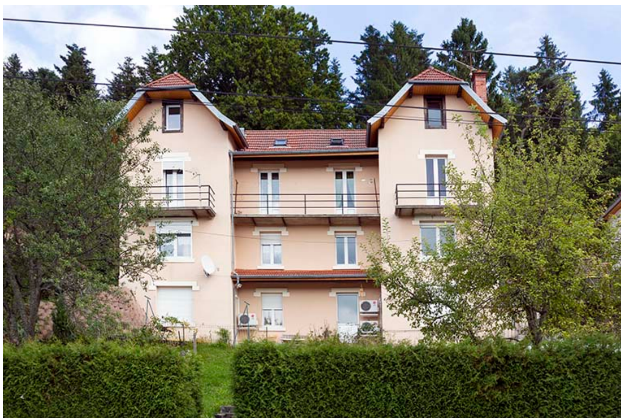
Immeuble n° 4 : façade côté vallée (ouest).
