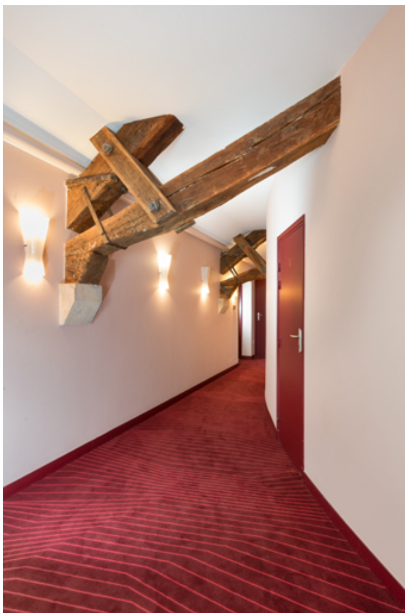
Couloir côté jardin desservant la 3e galerie.
