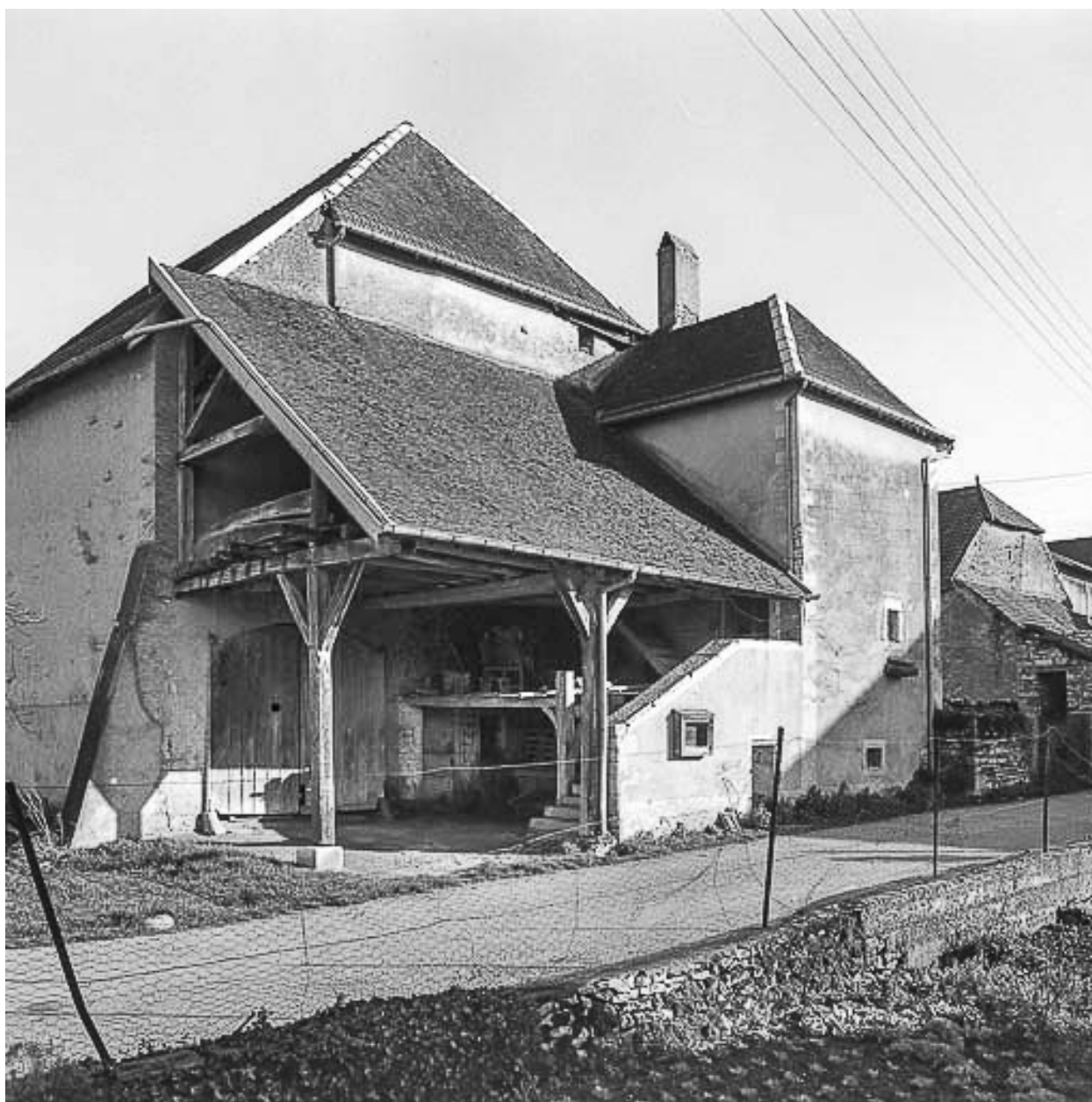
Détail : auvent et escalier extérieurs en 1984.
