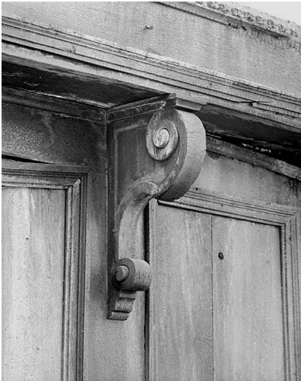
Détail d'une console soutenant le dais des dorsaux du mur sud du chœur, après l'incendie de 1987.
